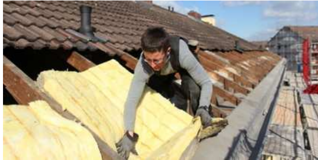
Abgeschwächte Vorgaben: Dämmung eines Hauses in Köln.
